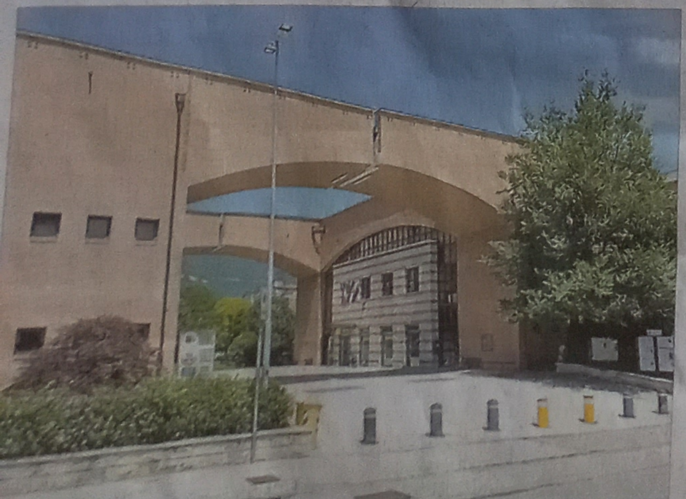
Andreatta con la divisa della Protezione Civile e sotto il centro civico del Brione
